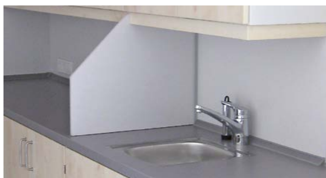
HPL-Arbeitsplatte mit flächenbündig eingebauter Edelstahlspüle
